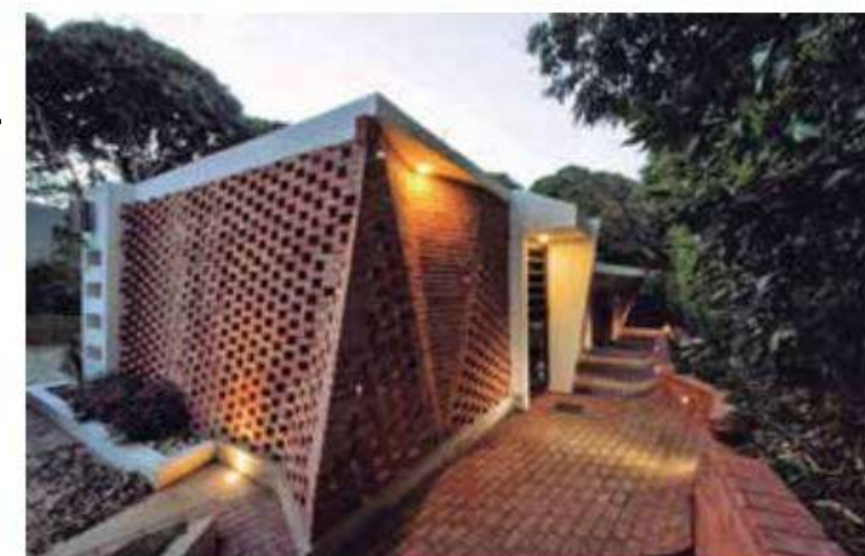
Ampliación Muro Corsé - Arq. Facundo Baudoin
